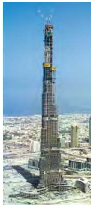
Fig. 1. Construcción del edificio Burj Khalifa
