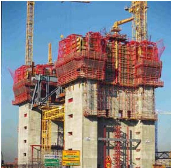
Fig. 8. Ejecución de Torre Bankia con dos núcleos en avance respecto a los forjados. Sistema Horca en el exterior
