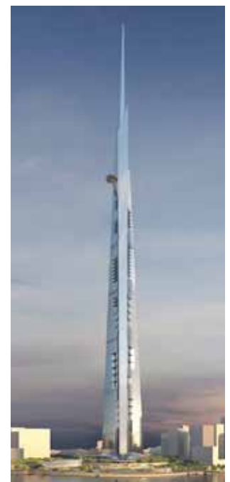
Kingdom Tower, Jeddah (en construcción, >1000m)
