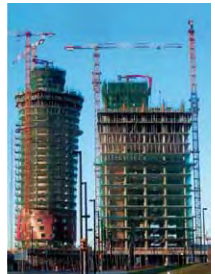
Fig. 22. Mesa de grandes dimensiones utilizada en Torre Isla Cartuja. Fig. 23. Extracción de una mesa en Torre Isla Cartuja. Fig. 24. Torres Fira Barcelona. Combinación de mesas perimetrales y encofrado modular de aluminio
