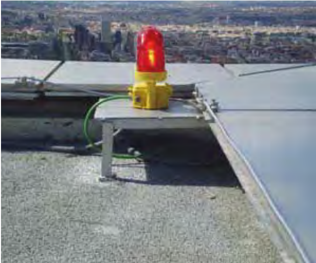
Fig. 7. Señalización de balizamiento en cubierta
