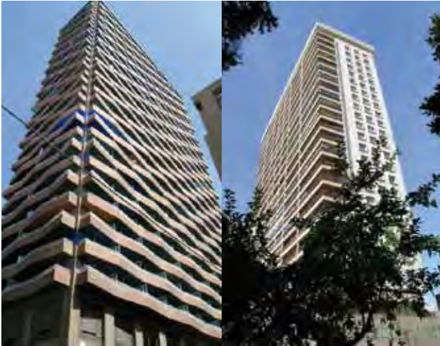
Fig. 8. Edificios de Muñoz y Solera
