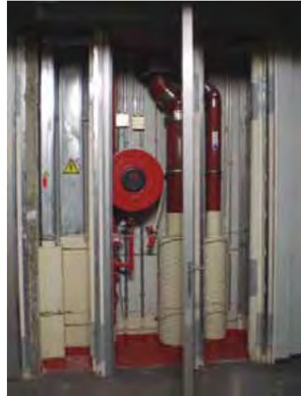
Fig. 4. Sectorización patio vertical
