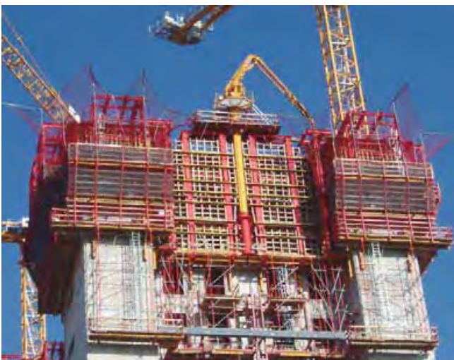
Fig. 9. Encófrados autotrepantes en Edificio Caja Madrid
