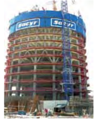
Fig. 15. Sistema de protección perimetral para las Torres Garellano en Bilbao. Fig. 16. Detalle de la protección perimetral en las Torres Garellano. Fig. 17. Sistema de protección perimetral en Torre PwC
