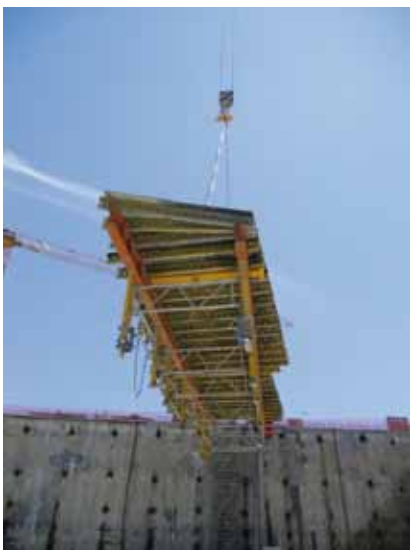
Fig. 22. Mesa de grandes dimensiones utilizada en Torre Isla Cartuja. Fig. 23. Extracción de una mesa en Torre Isla Cartuja. Fig. 24. Torres Fira Barcelona. Combinación de mesas perimetrales y encofrado modular de aluminio
