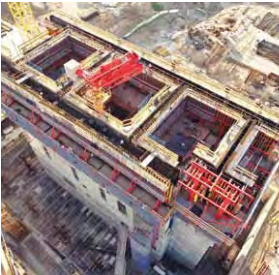
Fig. 6. Ejecución de Torre Cristal con los núcleos en avance respecto a los forjados. Combinación de sistemas Regular y Plataformas
