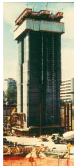
Fig. 2. Ejecución de uno de los núcleos de Puerta de Europa con encofrado deslizante
